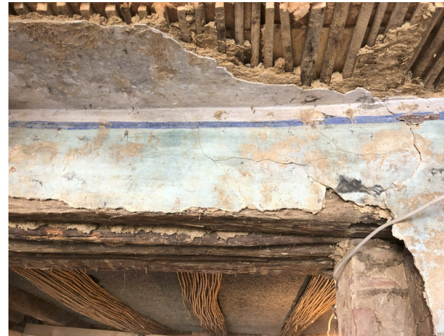
Freigelegte Wand im Bereich der ehemaligen Stallungen des Hauses. Foto: Matthias Bertram
