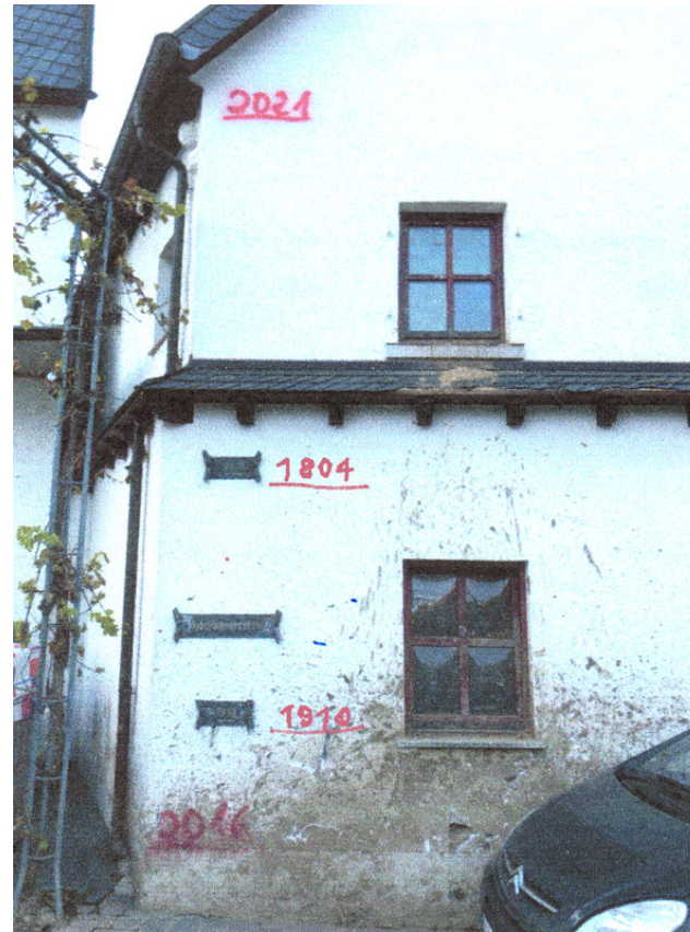
Hochwassermarken am ehemaligen Heymann-Haus in Dernau
