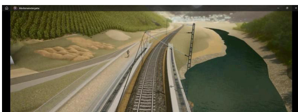
Animationsfilm Deutsche Bahn "Ahrstrecke" 1. Brückenpfeiler im Fluss. 2. Elektromaste auf Brückenpfeilern 3. Trassenführung im relativ niedrigen Hochwasserbereich am "Bergischen Hof"/Brücke unterhalb der Saffenburg
