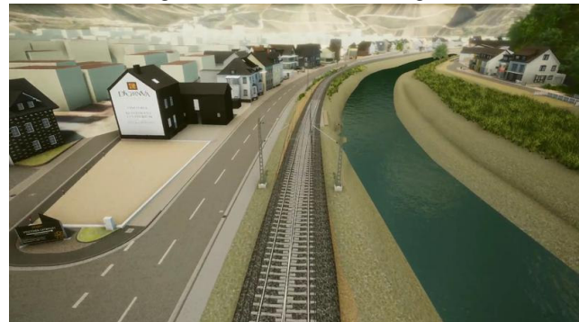
Oberleitungen und Masten in Dernau
