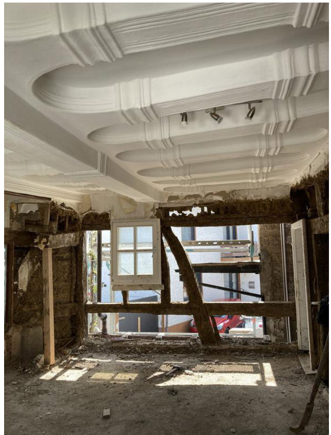
ehemalige Synagoge/Bethaus von Dernau mit Kölnner Decke
